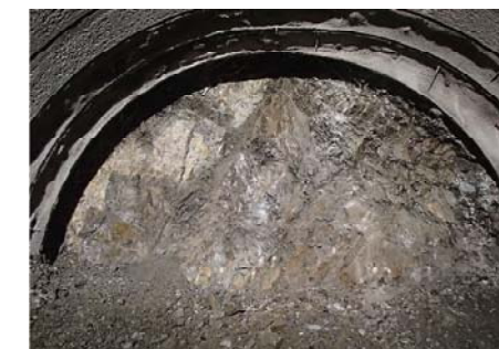
ファンカーテン起点側の切羽状況
