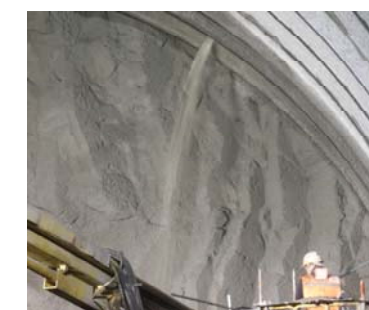
ロックボルト施工時の多量出水
