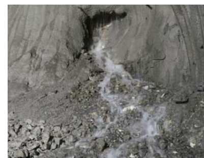
切羽における多量出水状況(約2t/分)
