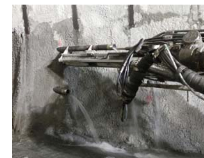
追加水抜き削孔における多量出水
