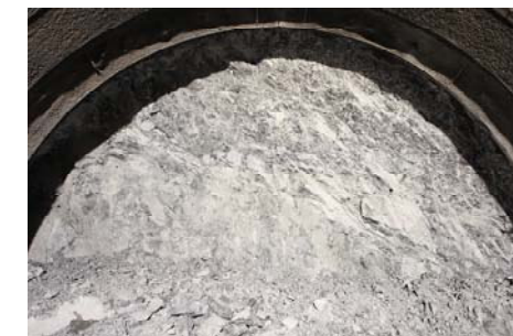
ファンカーテン起点側の切羽状況
