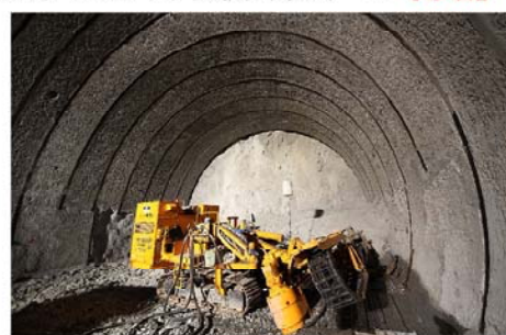
水平ボーリング状況
