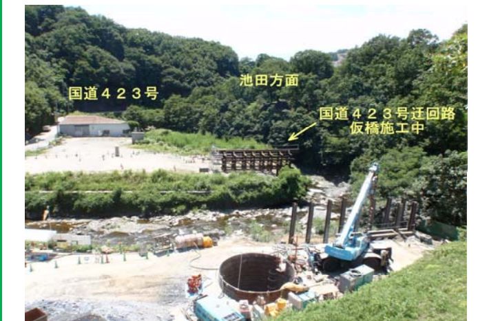
【高速道路 橋梁基礎施工中(箕面市止々呂美)】
