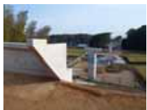
舟入川橋(下部工)工事 施工完了状況
