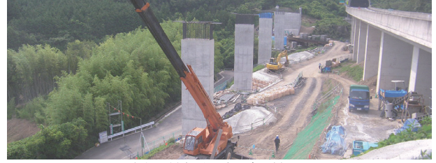
大谷川橋(下部工)工事の様子
