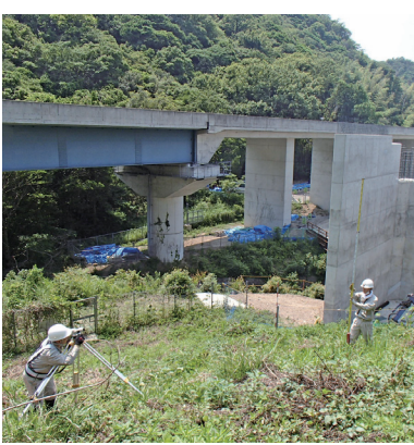
起工測量の様子
