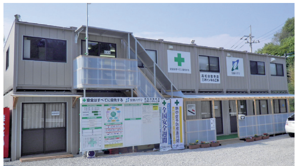
三木トンネル工事現場事務所
