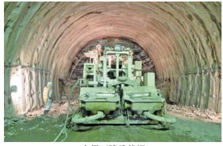
支保工建設状況
