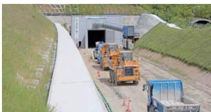
三木トンネル西坑口部
