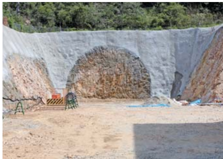
志度トンネル西坑口部
