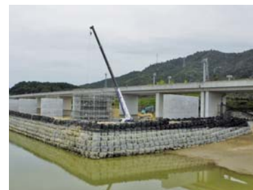
ため池内工事
