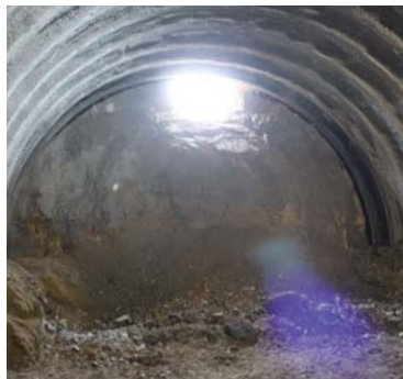
貫通の様子(削孔)
