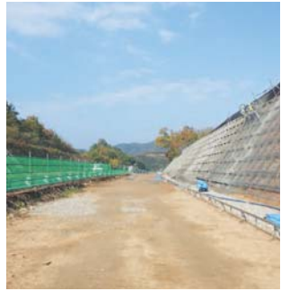
路床仕上げ後状況
