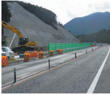
仮設防護柵撤去後状況
