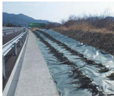
志度トンネル東坑口付近
