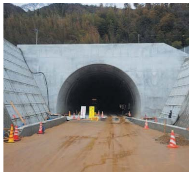
津田トンネル東坑口
