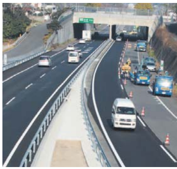
三木トンネル東坑口より東を望む
