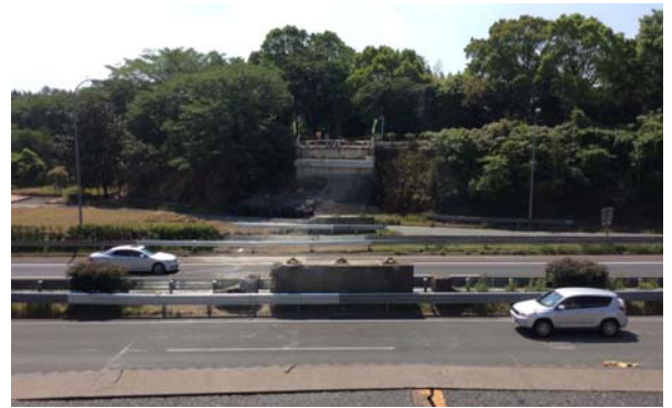
平成28年4月26日15時 通行止め解除（5月1日13時撮影）
