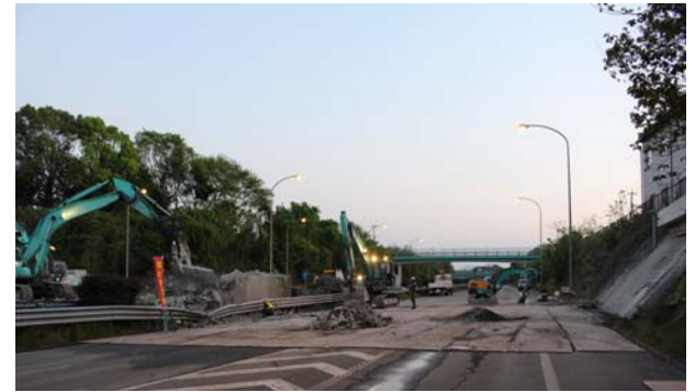
平成28年4月20日19時 撤去作業状況
