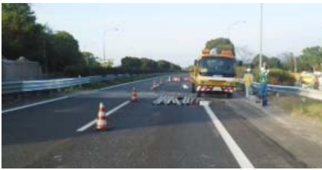
平成28年4月22日18時 撤去作業状況
