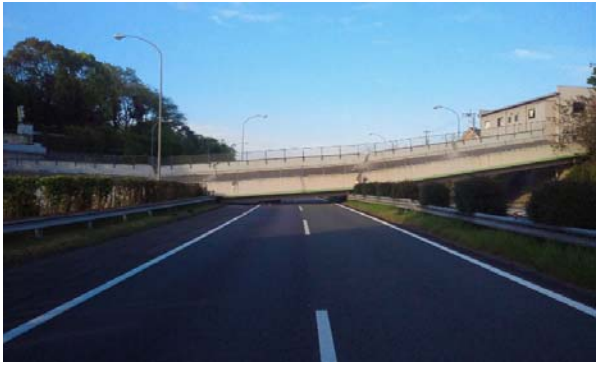
平成28年4月16日6時 被災後の状況
