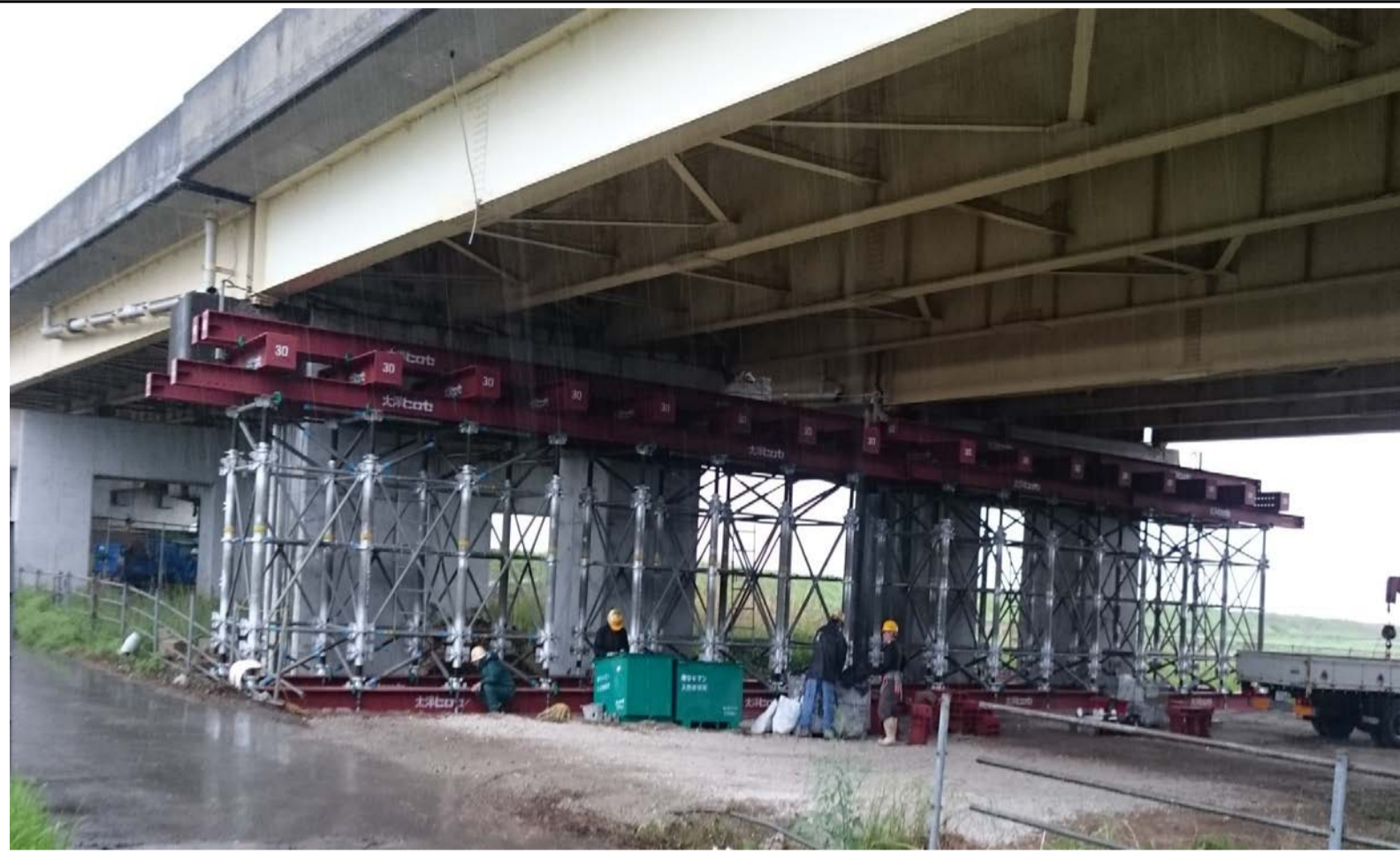
平成28年4月21日9時 応急復旧作業状況
