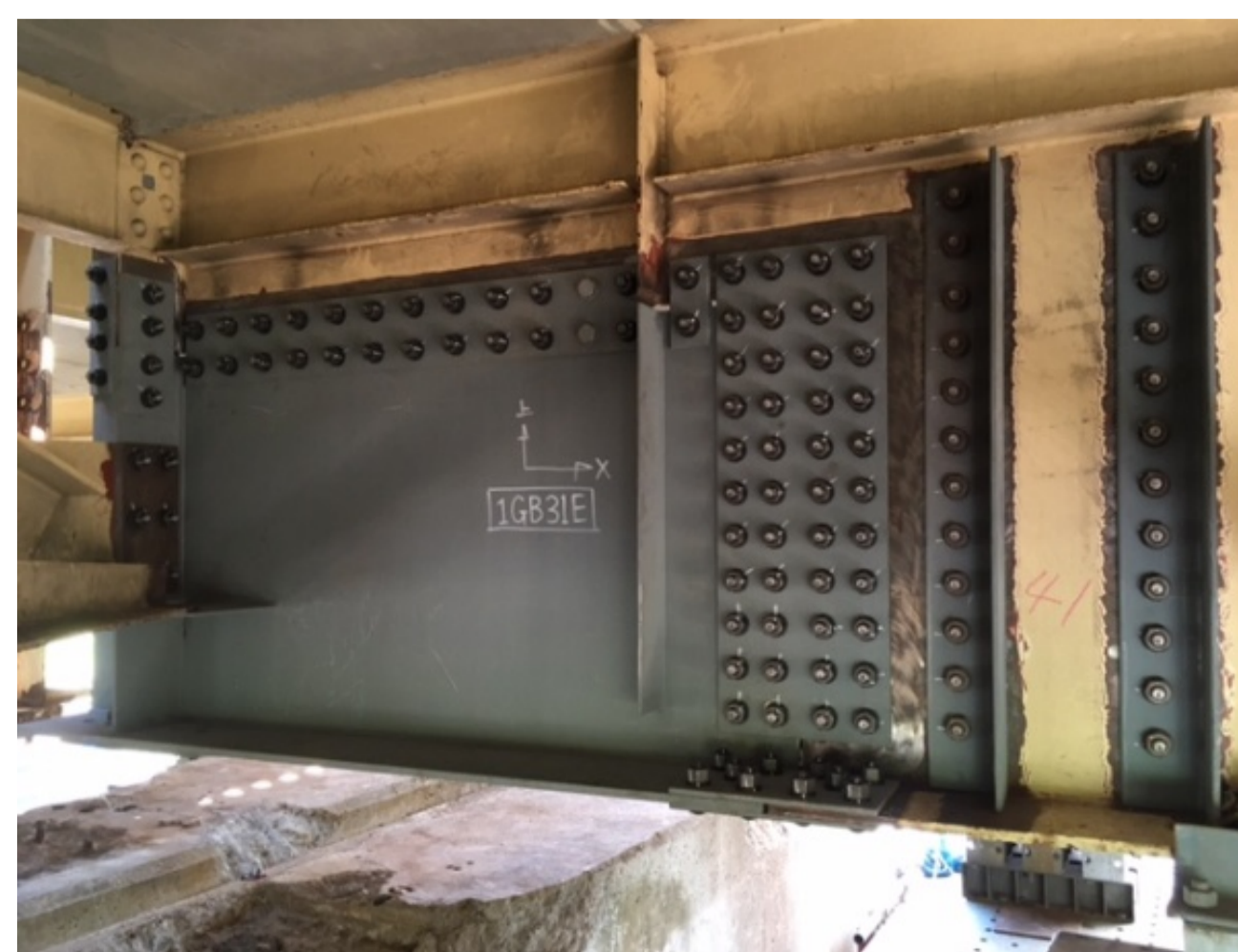
平成28年7月20日 本復旧作業状況（上り）
