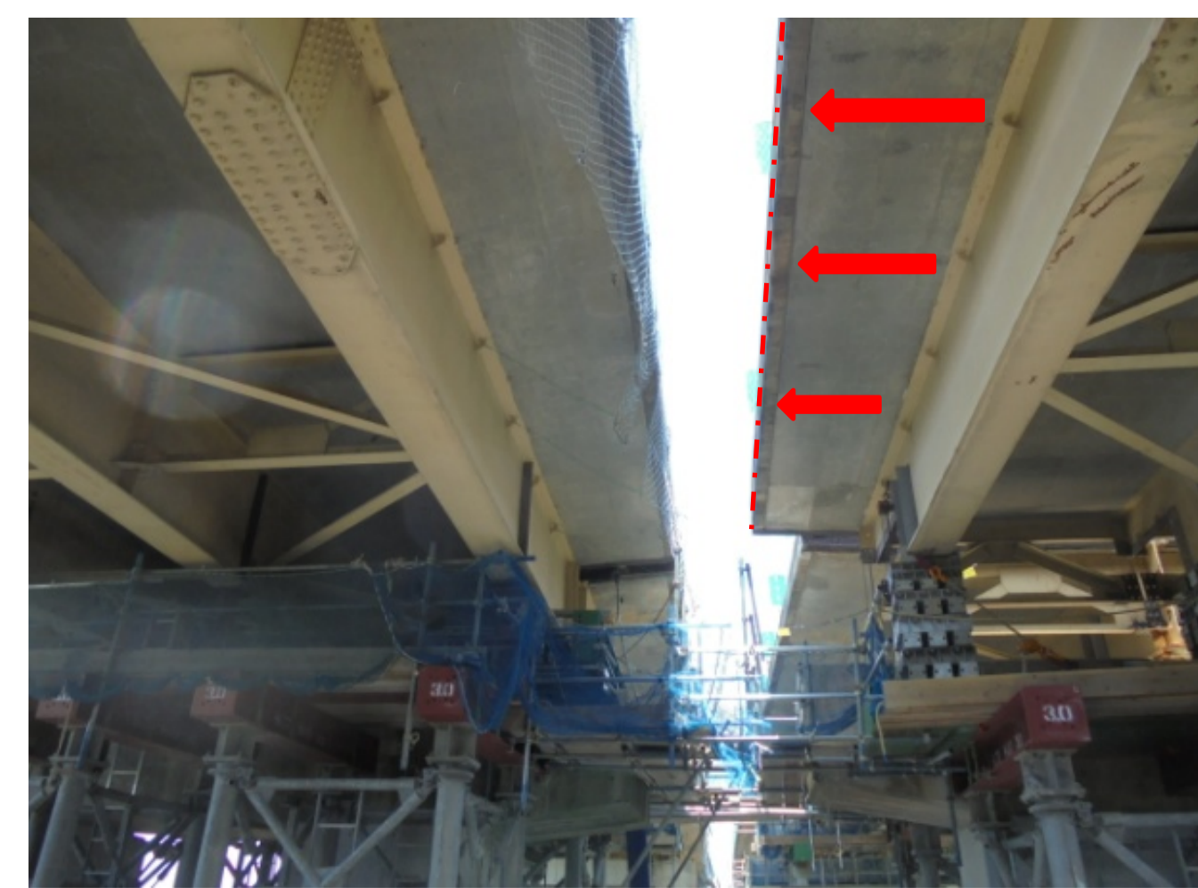
平成28年7月5日 本復旧作業状況（上り）
