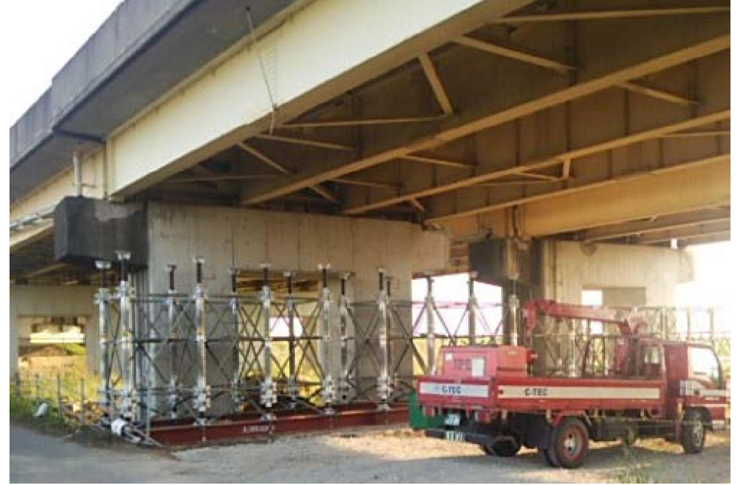
平成28年4月19日16時 応急復旧作業状況
