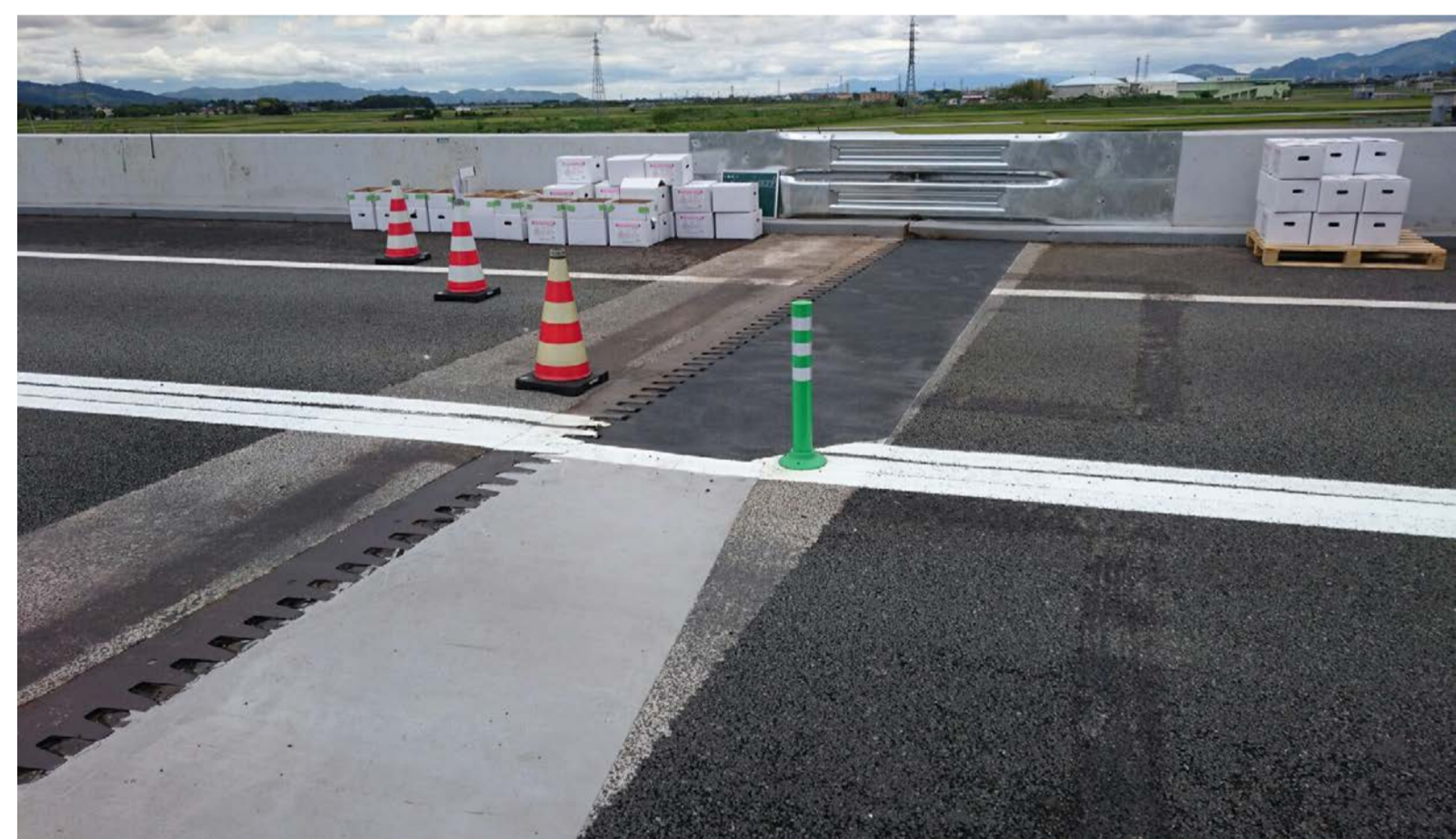
平成28年4月28日12時 応急復旧作業状況（上り）
