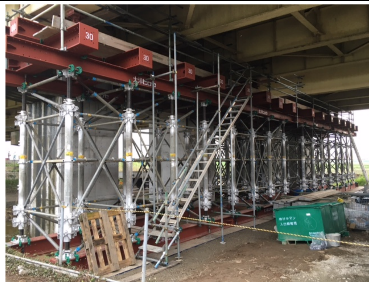
平成28年4月24日10時 応急復旧作業状況
