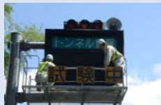
情報板の点検
