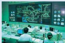
道路管制センター
