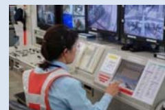
車両監視盤の操作
