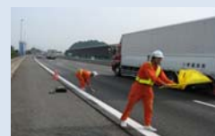
ポットホールの緊急措置
