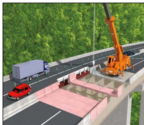
路面を構成する床版や橋桁の修繕、架け替えを進めていきます
