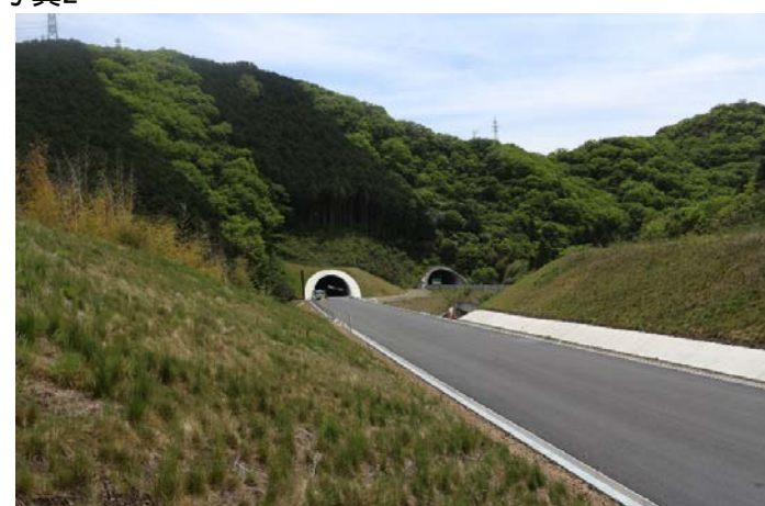
【南唱谷トンネル西坑口付近】 写真2
