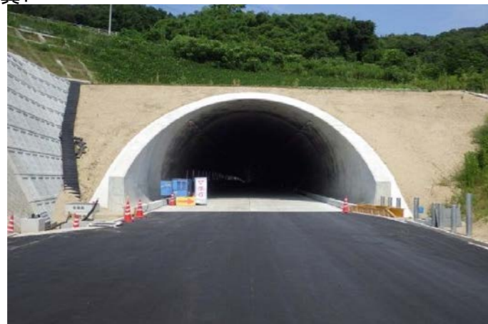
【三木トンネル北坑口付近】 写真1
