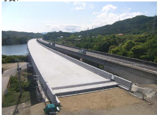
【宮池橋(上り方面)】 写真1
