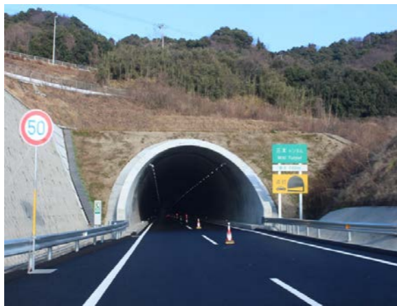
【三木トンネル西坑口付近】 写真1
