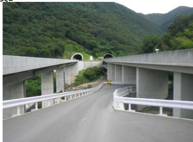
【大坂トンネル北坑口付近】 写真2
