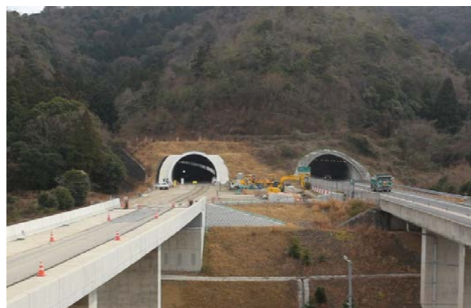
【北唱谷トンネル北坑口付近】 写真2
