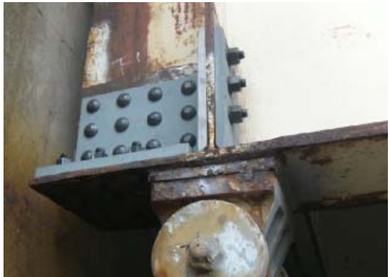
鋼桁の当て板補修
