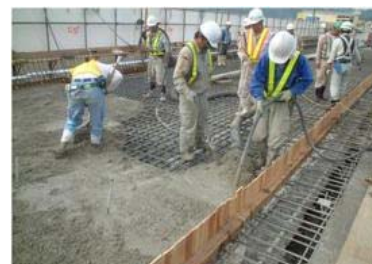
床版上面の部分打替
