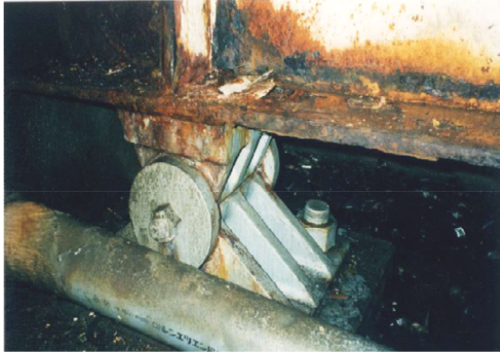
鋼桁の劣化
