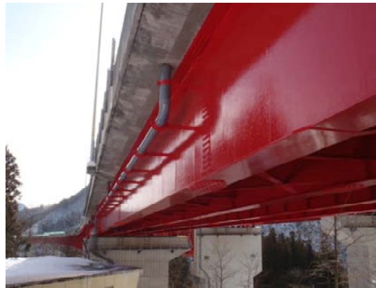
鋼桁の塗替塗装
