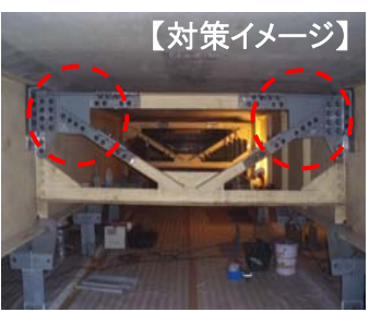
桁補強 (対傾構の増設など)
