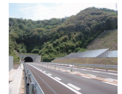
太陽光パネル
