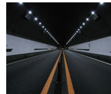
トンネルLED照明
