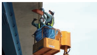
橋梁たつき点検
