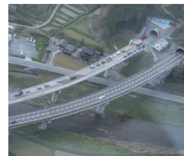
車線拡幅工事
