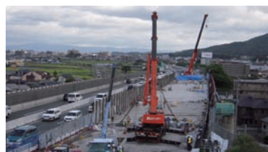
橋梁床版の全面補修工事
