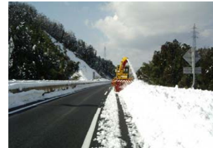
走行車線を一時的な排雪場所として、走行可能な車線を確保
