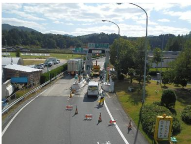
《ETCレーン工事規制のようす》
