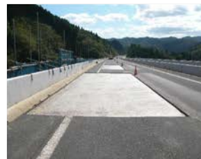
《新しいコンクリートの施工》
