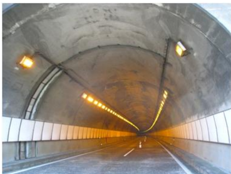
《照明取り替え工事前》
