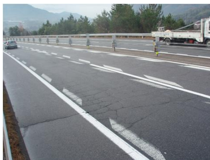
《路面の損傷状況》
