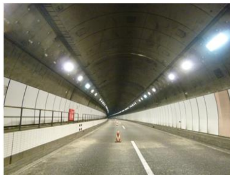
《照明取り替え工事後》
