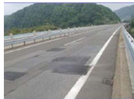
《橋梁床板の損傷に伴う路面の損傷》
