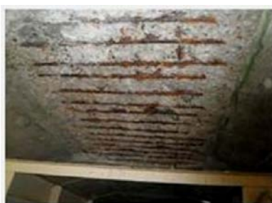
《橋梁床版下面部の損傷》
