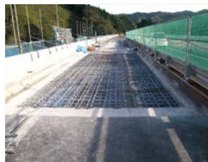
《損傷部の除去後》
