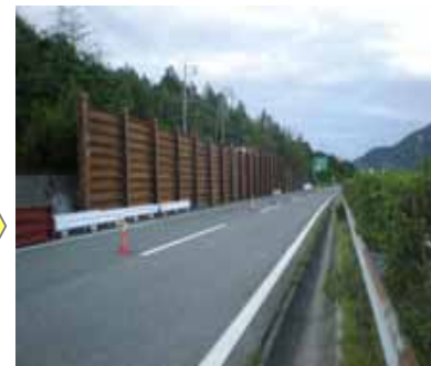
被災後4日で応急復旧を完了
