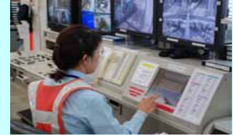
車両監視盤の操作
