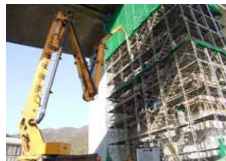
橋梁の耐震補強工事
