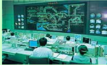
道路管制センター
