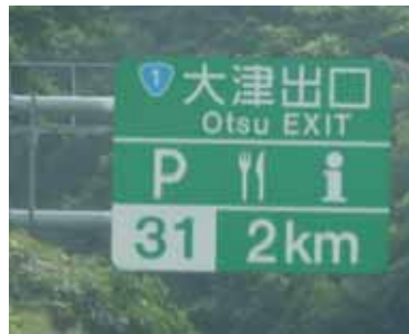
文字サイズ2割拡大、超高輝度反射シート採用
