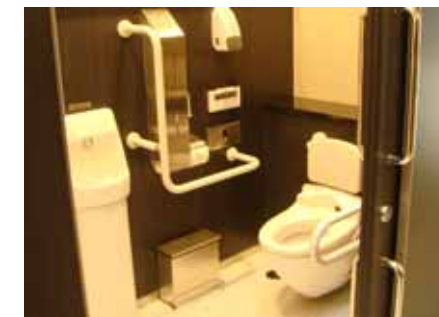
暖房・洗浄便座とオストメイト対応トイレ (山陽自動車道 龍野西SA下り)
