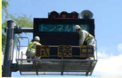
情報板の点検
