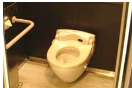
暖房・洗浄便座 (山陽自動車道 龍野西SA下り)
