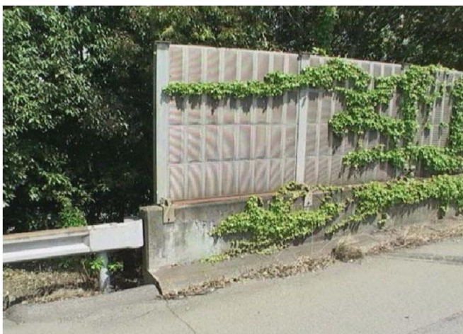
関越道衝突事故地点の事故前の状況 (平成 23 年 5 月撮影)
