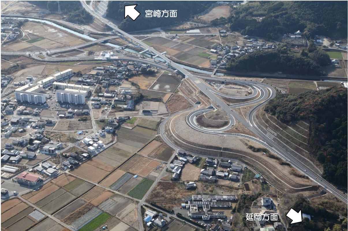
写真① ひゅうが 【日向インターチェンジ付近 平成25年12月23日撮影】
