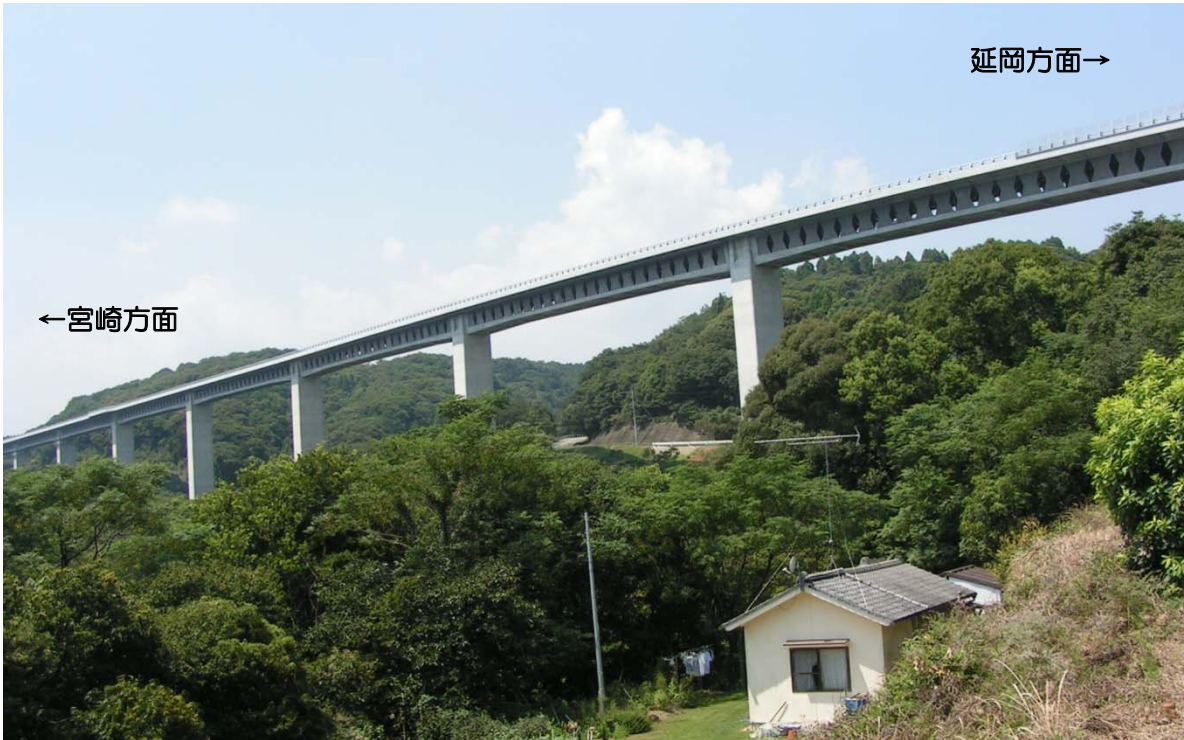
写真② てらさこ 【寺迫ちょうちよ大橋(日向市大字寺迫付近) 平成25年8月28日撮影】
