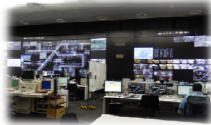
【道路管制センター】高速道路の安全を守る「司令塔」のような役割を担う管制センター。建物の内部を見学します。
