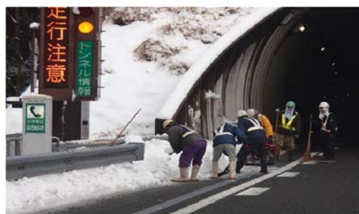
人力による除雪作業
