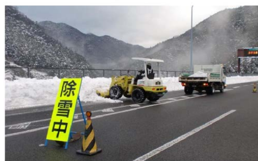
追越車線優先除雪による車線確保
