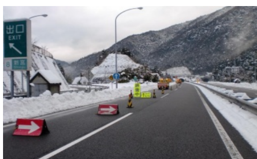
追越車線優先除雪による車線確保
