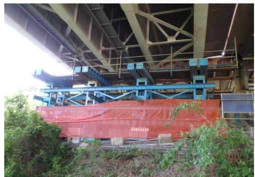
仮受架台設置(上り線)
