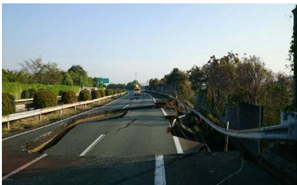
盛土のり面崩落・路面陥没
