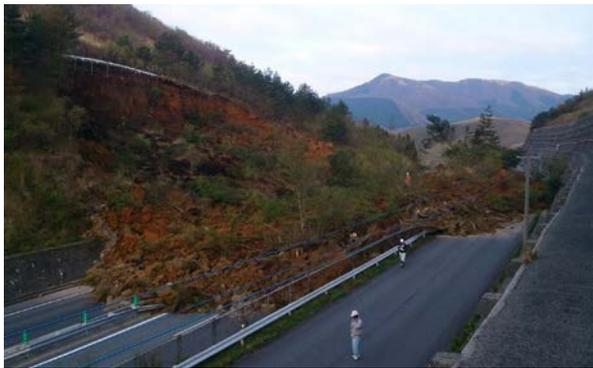
切土のり面土砂崩落
