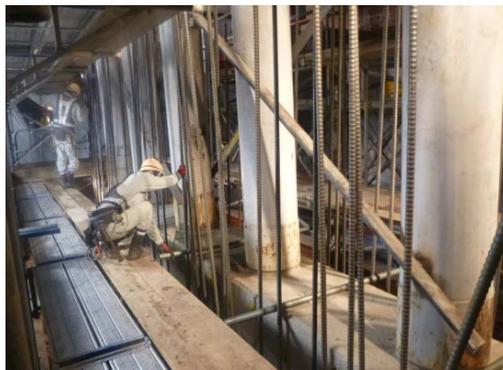
橋脚補強状況(コンクリート巻立て)
