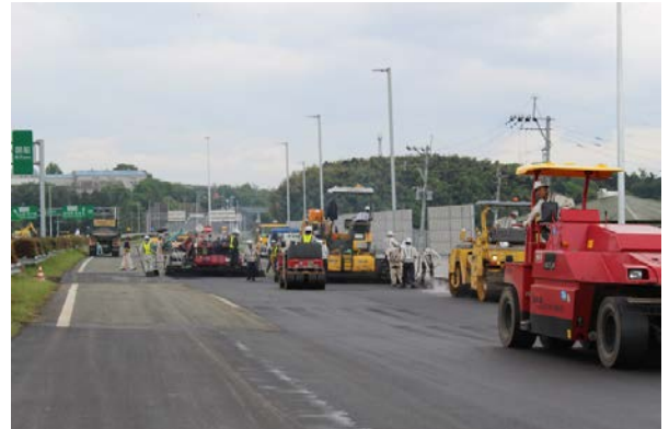
舗装補修状況
