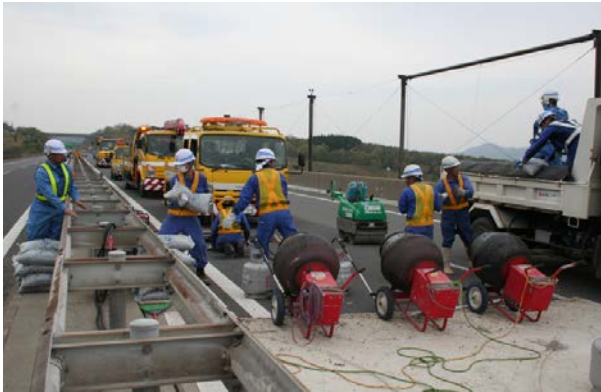
舗装補修状況
