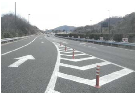
《本線合流部の逆走対策》
