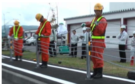
《復旧工事(イメージ)》
