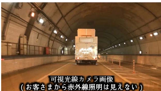
参考図-3 赤外線照明による点検状況(お客様から見えない配慮)
