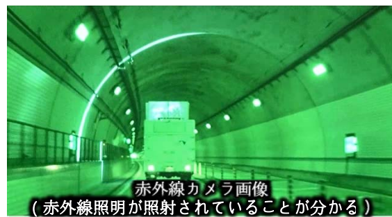
参考図-3 赤外線照明による点検状況(お客様から見えない配慮)
