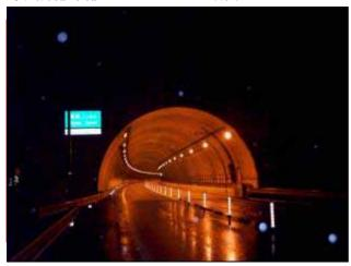
○車線分離標ラバーポールの高さ変更(650mm 800mm)設置間隔の変更(10m 5m ピッチへ)
