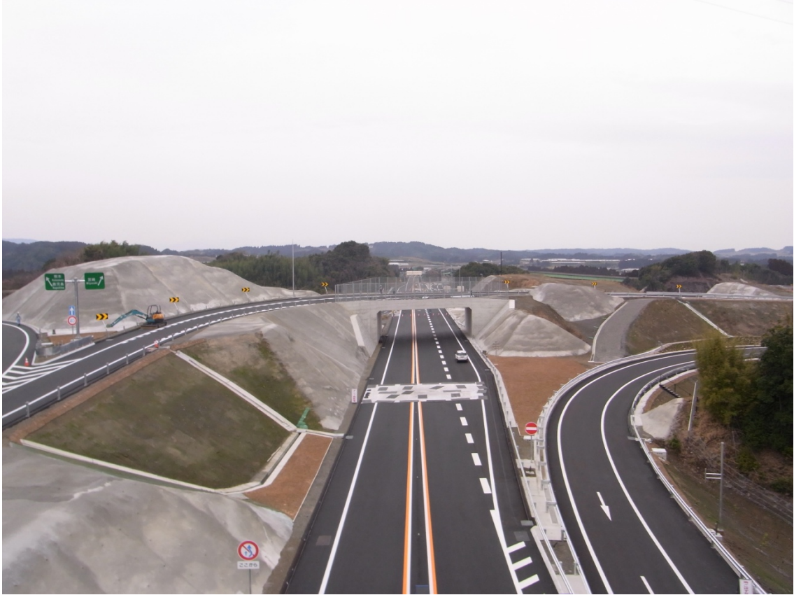
写真②【KP340.3付近から清武JCT方面を望む 平成25年 2月 7日撮影】
