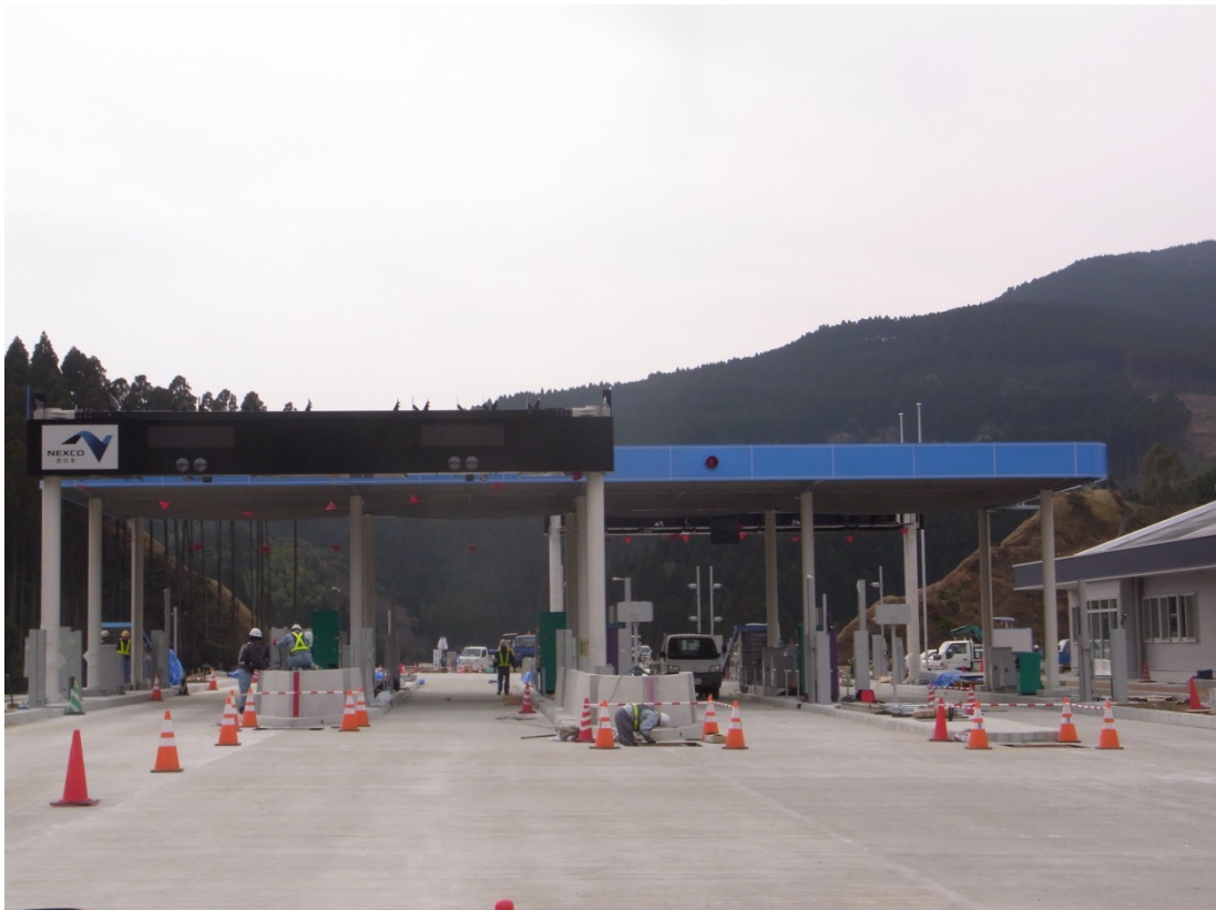
写真⑤【清武南本線料金所付近 平成25年 2月 7日撮影】
