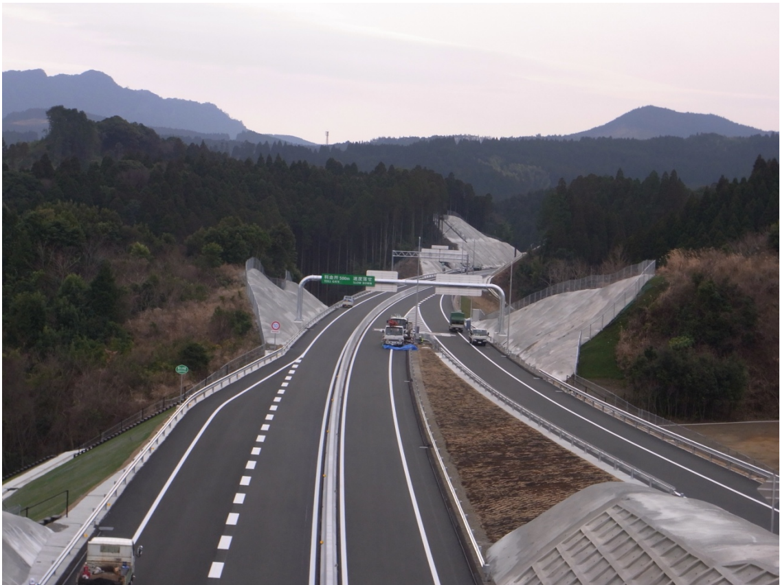
写真③【KP340.3付近から清武南IC方面を望む 平成25年 2月 7日撮影】
