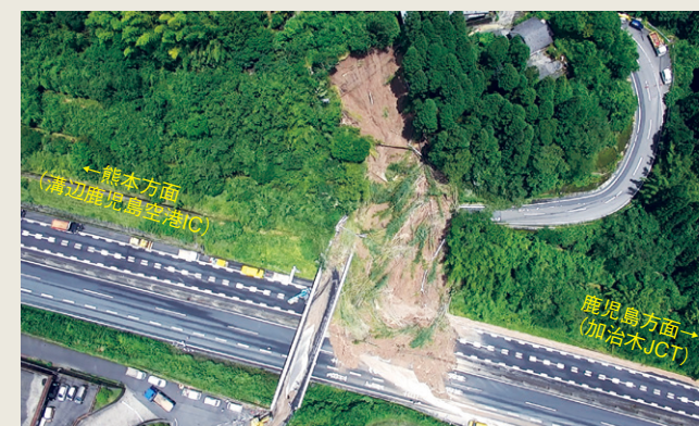
下り線被災状況(区域外からの土砂流入)
