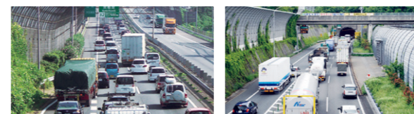
名神高速道路(上り線)京都東IC付近 京滋バイパス(上り線)宇治TN付近
