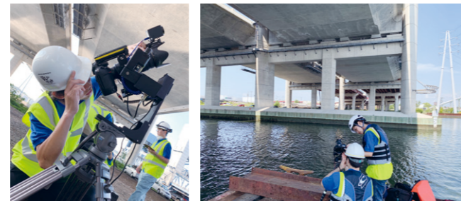
Pearl Harbor Memorial Bridge 点検の様子 (アメリカ)
