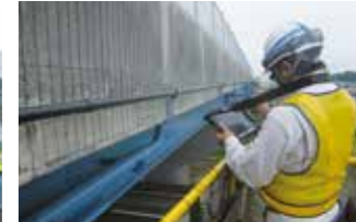
タブレットでの点検記録
