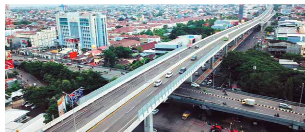
開通した有料道路（インドネシア マカッサル）
