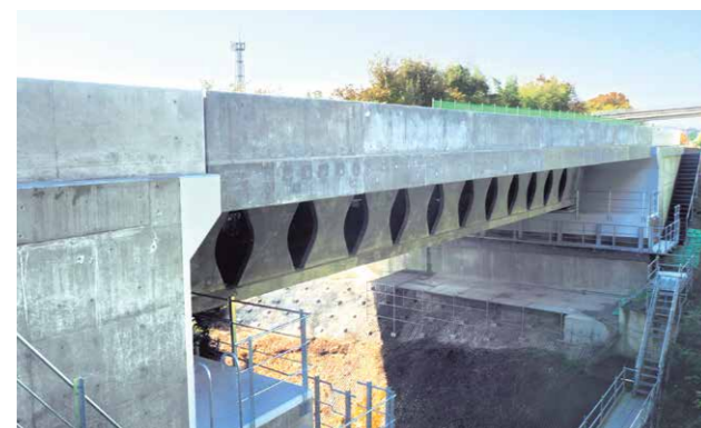
徳島自動車道 別荘谷橋の完成状況
