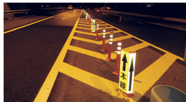
公募により導入したLED発光体付ラバーボールウィングサイン。IC等の合流部で進行方向の案内を強化 (中国道 ひょうご東条IC)
