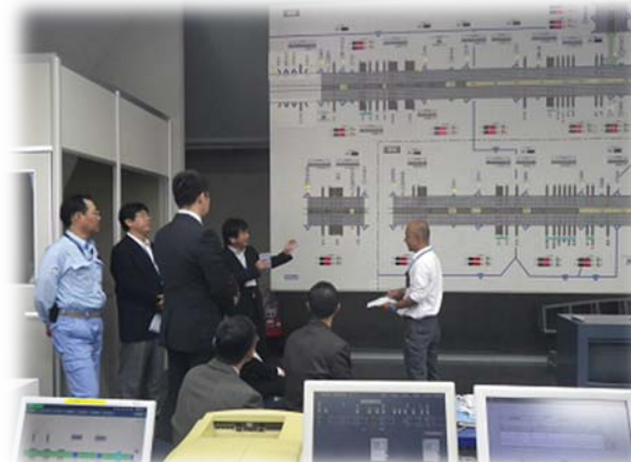
NEXCO交通管制室調査(H24.10実施)
