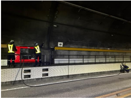
<トンネル非常用設備点検>
