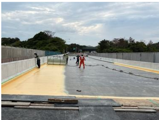
(床版防水工事)
