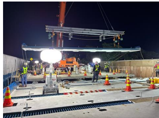
(新しいコンクリート床版の設置状況)
