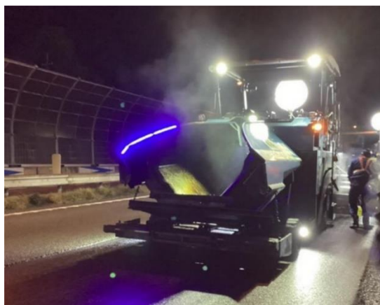
《施工イメージ》
