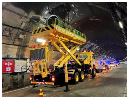
《ジェットファン設備点検(作業イメージ)》
