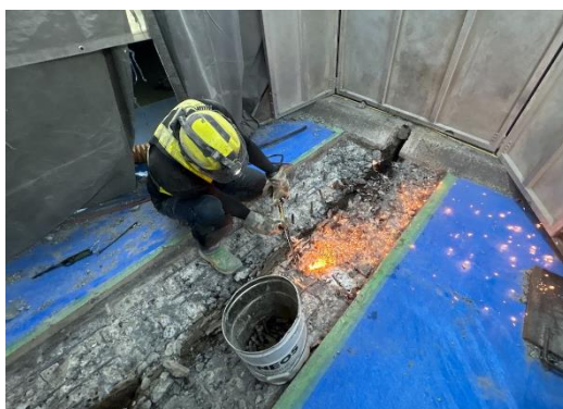
《施工イメージ》
