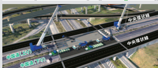
終日通行止めによる作業イメージ
