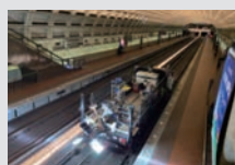
トンネル画像点検
