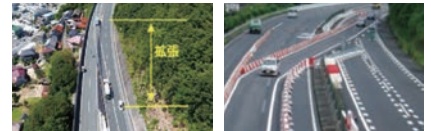
中央分離帯開口部の拡張 仮設車線を造成
