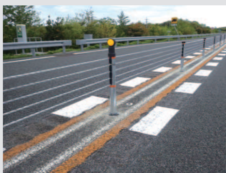
ワイヤロープ設置
