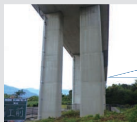
コンクリート中空断面橋脚
