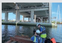
橋梁画像点検
