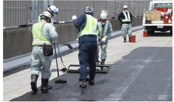
床版防水工の施工状況
