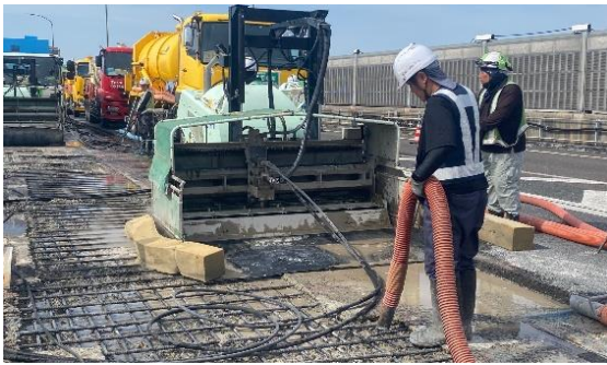
老朽化した床版の補修状況
