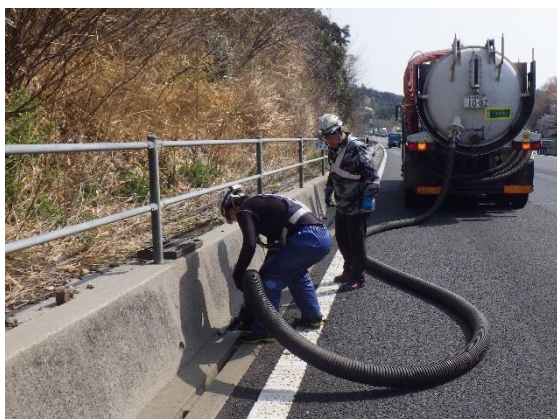
排水溝の清掃
