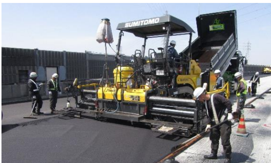
新たな舗装の施工状況
