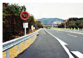
可変式速度規制標識の設置
