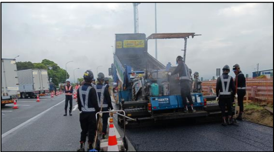
【舗装施工状況】
