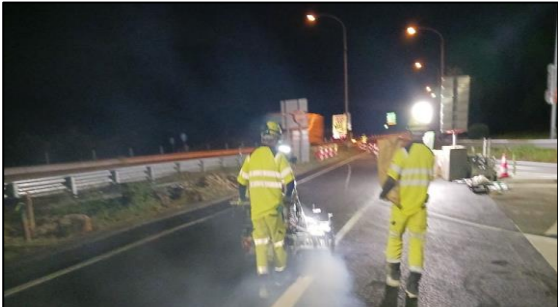
【路面標示施工状況】
