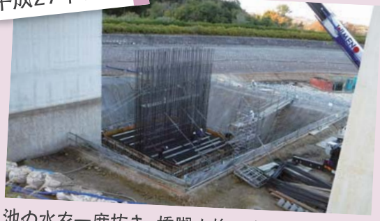
池の水を一度抜き、橋脚の施工が始まりました。
