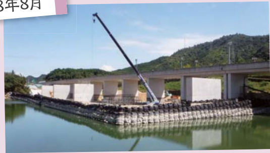
農繁期は宮池の貯水量を確保するため、池を区切って橋脚を施工しました。
