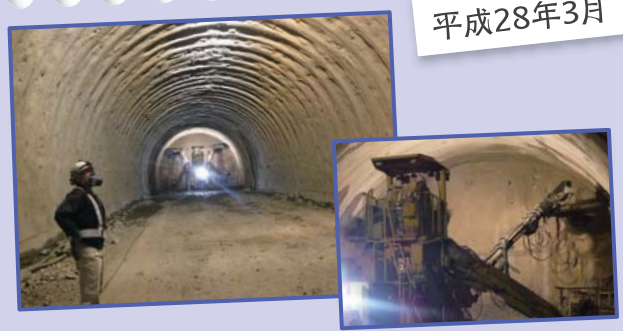
トンネルを掘削・発破し、工事を進めました。
