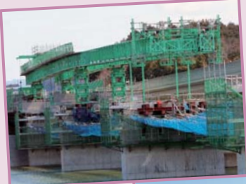
橋桁を現場の近くで製作し、架けるという方法を取りました。
