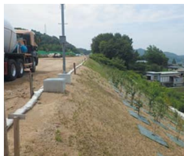
津田トンネル西坑口法面
