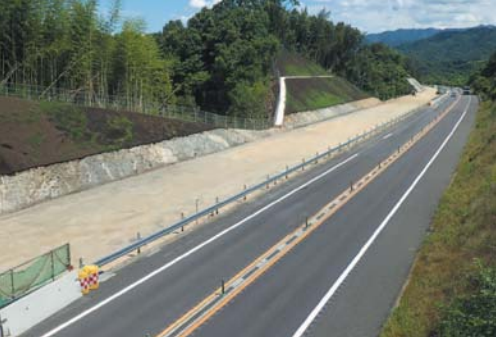
土工部整備状況
