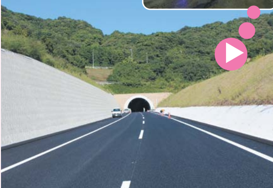
トンネル貫通▶
