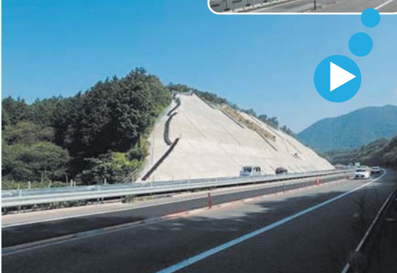
掘削・モルタル吹付け▶
