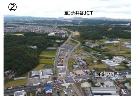
ひらのひがし 平野東高架橋 整備状況
