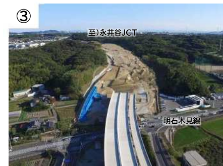
すがの 菅野高架橋～土工 整備状況
