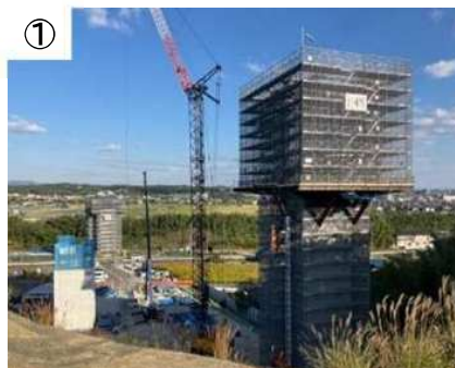
あかしがわ 明石川橋 整備状況
