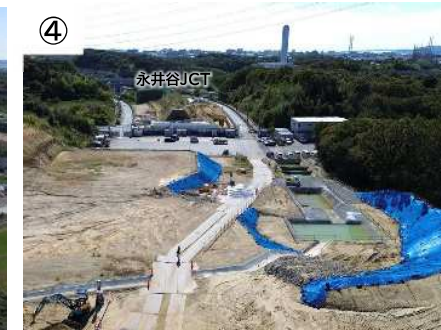
ながいけに 永井谷土工部 整備状況
