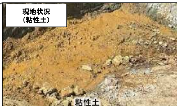
現地発生土の 改良状況
